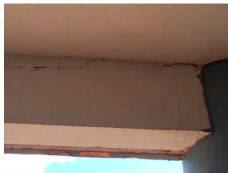
Fig. 23 – Collège de Dembeni : Gauche : Fissure importante sur toute la hauteur au niveau d'un joint de dilatation. Droite : poutre soutenant le R+1 fissurée à la liaison avec la dalle. (photos-AS-BCSF).
