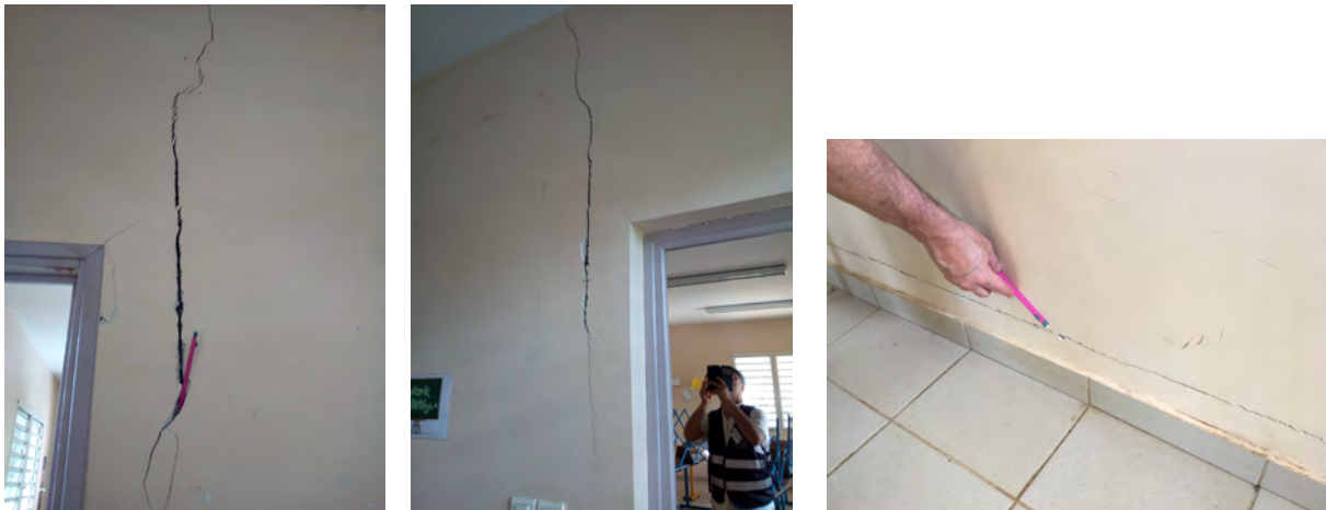
Fig. 22 – Collège de Dembeni. Gauche et centre : Fissure ouverte centimétrique. (photos-MB-OPGC). Droite : Base du mur fissuré et bombé vers l'extérieur en relation avec la fissure (photos gauche et centre) sur mur perpendiculaire. (photo-AS-BCSF).
