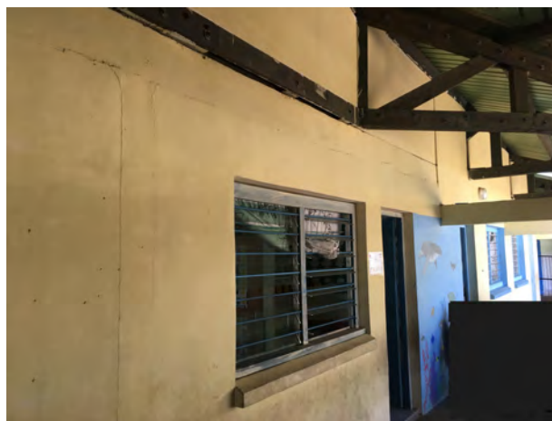
Fig. 27 : Ecole de M'Bouini avec fissures millimétriques à toutes les liaisons ossature/remplissage révélant toute la géométrie de l'ossature. Dégâts de degré 1 dans une structure de classe de vulnérabilité C. (photos-AS-BCSF).
