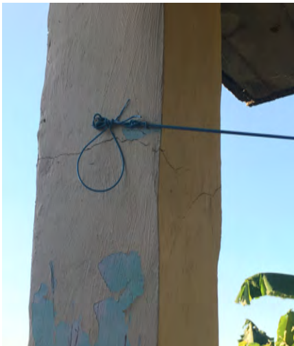
Fig. 44 : poteau avec fissures traversantes horizontales. Exemple de fissures dans les murs (degré 2 vulnérabilité B). (photos-AS-BCSF).
