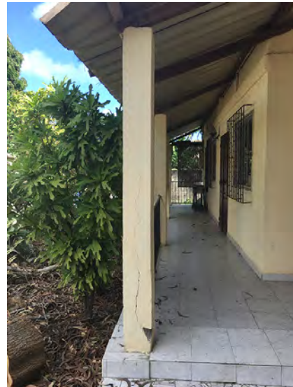
Fig. 42 : Ecole primaire Mongome, en ossature béton armée et remplissage en maçonnerie RDC : fissures fines avec une faible ouverture murs à partir du coin des fenêtres + fissures sur un poteau qui soutien l'avancée du toit. (photos-AS-BCSF).
