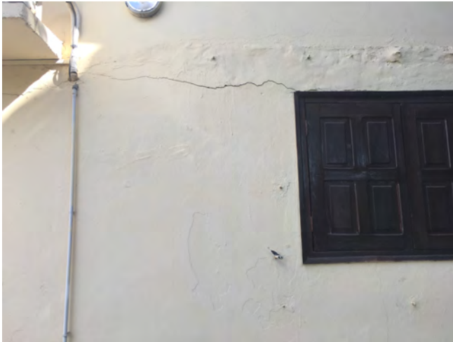
Fig. 42 : Ecole primaire Mongome, en ossature béton armée et remplissage en maçonnerie RDC : fissures fines avec une faible ouverture murs à partir du coin des fenêtres + fissures sur un poteau qui soutien l'avancée du toit. (photos-AS-BCSF).
