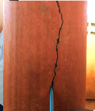
Fig. 45 : Ecole maternelle « Sada I M'Tsangani », ossature béton armé avec remplissage en maçonnerie R+1. RDC transparent. Quelques poteaux en béton fissurés en leur centre dans le sens de la hauteur et à leur pied. (degré 1 à degré 2 pour une vulnérabilité estimée à B)
