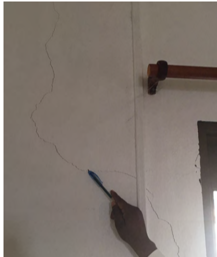
Fig. 44 : poteau avec fissures traversantes horizontales. Exemple de fissures dans les murs (degré 2 vulnérabilité B). (photos-AS-BCSF).
