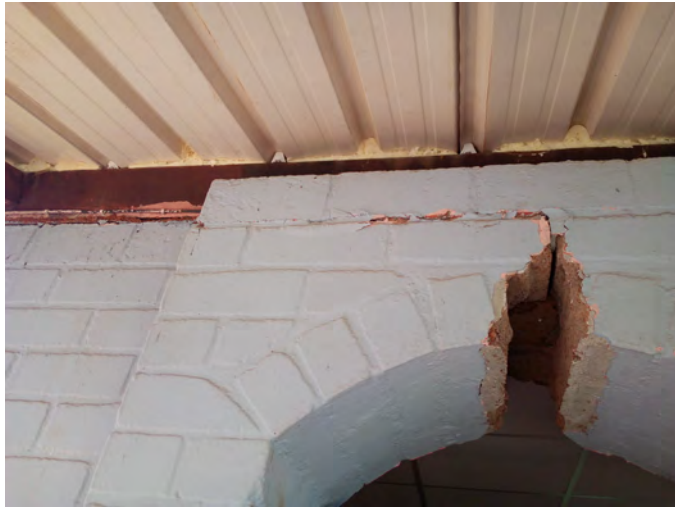
Fig. 24 – Ecole élémentaire de Hajangua type case SIM: Fissure liée au mouvement relatif de la charpente par rapport à la maçonnerie et perte de l'élément central d'une arche. Les dégâts sont de degré 2 pour une classe de vulnérabilité A.
