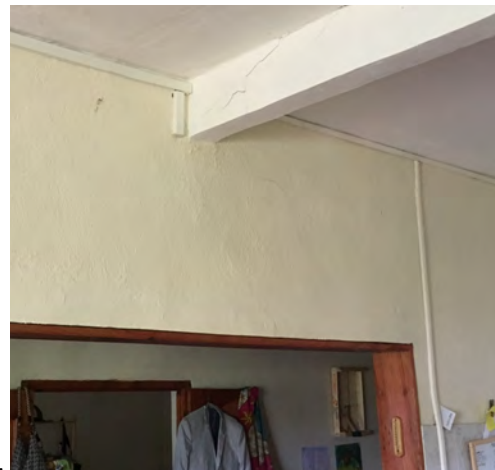
Fig. 8 : Fissuration d'une poutre porteuse d'une maison individuelle en dur (vulnérabilité C).
