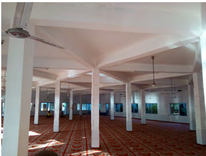
Fig. 46 : La mosquée qui jouxte l'école « Sada I M'Tsangani », structure ossature béton armé « en étoile » avec un remplissage en maçonnerie pour les parois extérieures. Droite : poutres reposent directement sur les murs en maçonnerie induisant une fissuration avec ouvertures. Dégâts de degré 2 pour une vulnérabilité estimée B.
