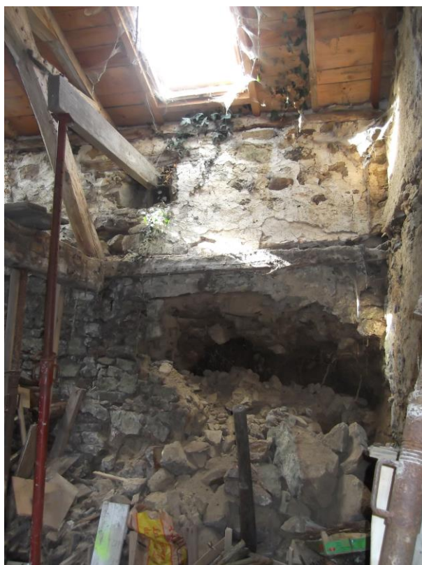
Photo 1 - Mur en maçonnerie de pierres (vulnérabilité A) Breuil-Chausée (dépt. 79).
