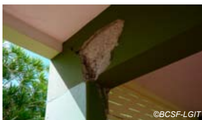
Fig. V-141 : Le Lamentin, école primaire des Roches Carrées.
