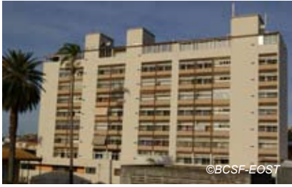
Fig. V-121 : Fort-de-France Immeuble Plein Ciel, façade est.
