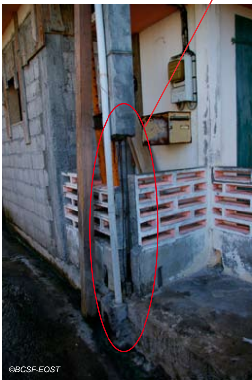
Fig. V-16 : Grand-Rivière, détail du pilier.
