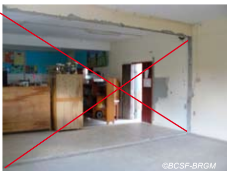
Fig. V-28 : Le Lorrain, école Léon Cécile Carabin emplacement de l'ancien mur (cloison)
