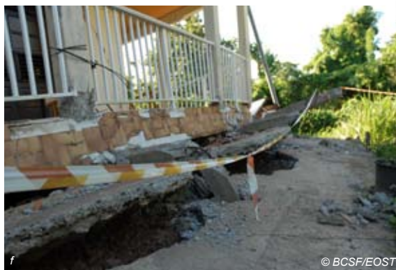
Fig. V-157 : Ducos - Détails de la seule maison individuelle affectée par de forts dégâts à Ducos (dommage de niveau 5) - quartier Saint-Pierre.
