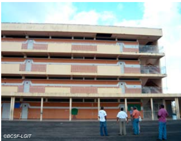
Fig. V-76 : Gros-Morne - école La Fraîcheur, vue générale.
