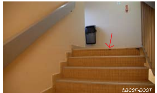
Fig. V-86 : La Trinité - (CH L.D), éclatement de carrelage sur nez de marche.
