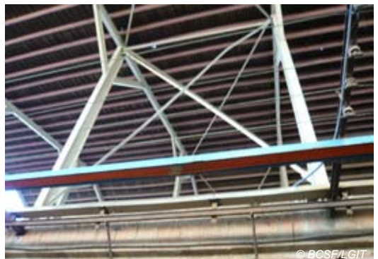
Fig. V-166 : Trois-Ilets, poterie, flambement d'une croix de St.-André dans les séchoirs.
