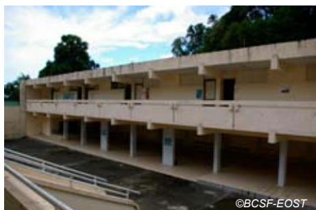
Fig. V-12 : Grand-Rivière - Bâtiment de l'école maternelle (vue générale).
