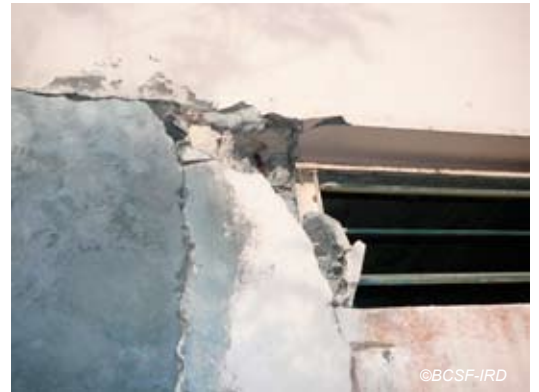
Fig. V-25 : Le Lorrain, lieu-dit Fonds Gens Libres – maison individuelle. RC+1.
