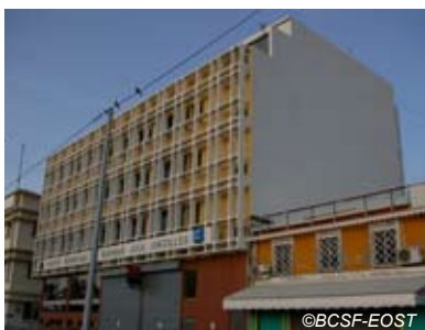
Fig. V-125 : Fort-de-France Immeuble SGBA façade est.
