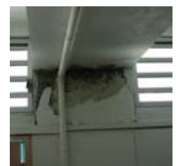
Fig. V-204 : Eclatement de béton de couverture.
