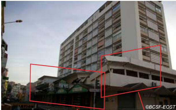
Fig. V-122 : Fort-de-France Immeuble Plein Ciel, façade ouest.
