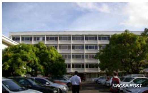
Fig. V-133 : Fort-de-France - bâtiment D de la préfecture - 4 niveaux (structure portique en béton armé et remplissage).
