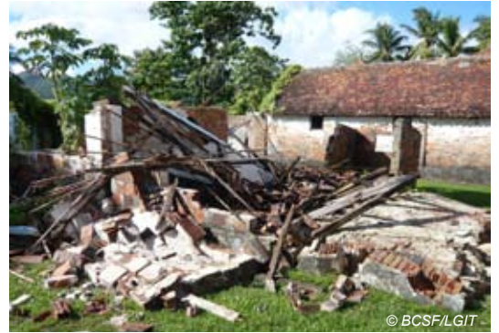
Fig. V-167 : Trois-Ilets, poterie, effondrement d'une cabane d'esclave en maçonnerie de briques.
