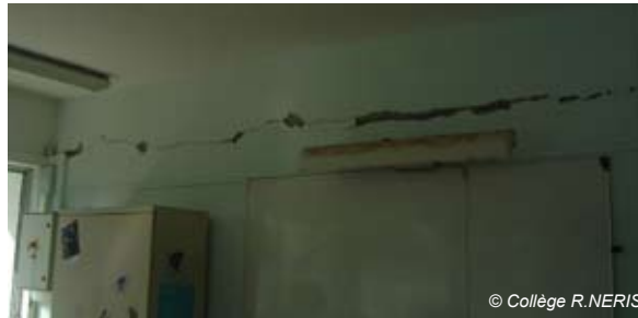
Fig. V-206 : Le Marin - lycée Raymond Néris, bâtiment D.
