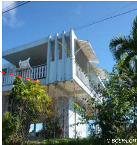
Fig. V-218 : Sainte-Luce - maison individuelle - partie en porte-à-faux.
