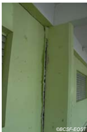
Fig. V-146 : Le François - Ecole Anne Marc - éclatement de mortier en pied de poteau et début de flambement des armatures.
