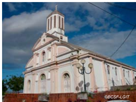
Fig. V-74 : Gros-Morne, façade de l'église.
