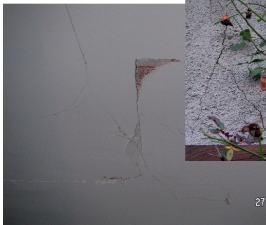
Fig. 24 - Diverses fissures sur murs intérieurs et extérieurs à Arrayou-Lahitte (8,5 km de l'épicentre) - photos DDE65
