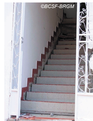
Fig. IV-18. Décrochement de l'escalier de l'hôtel.
