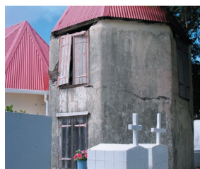
Fig. IV-15. Dommages sur le clocher et le fronton de l'église (mur en moellons - vulnérabilité A).
