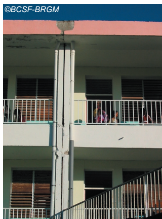
Fig. IV-78. Dégâts au niveau du joint de dilatation.
