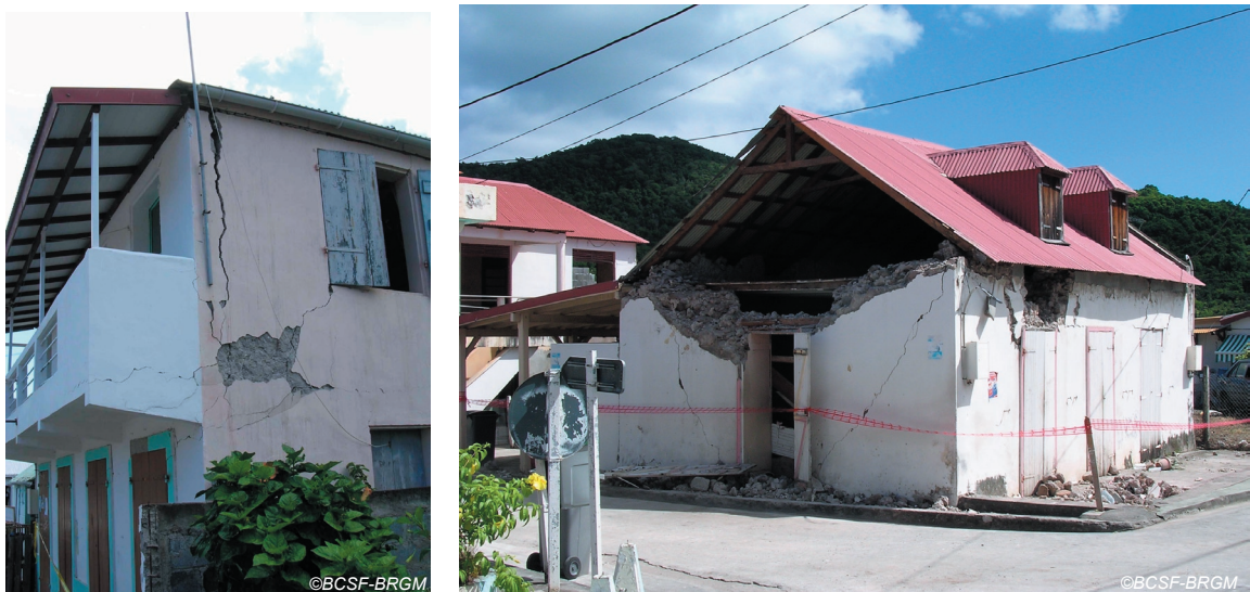
Fig. IV-20. Dommages de niveau 3-4 sur maisons individuelles (vulnérabilité A) au centre du bourg de Petite-Anses.
