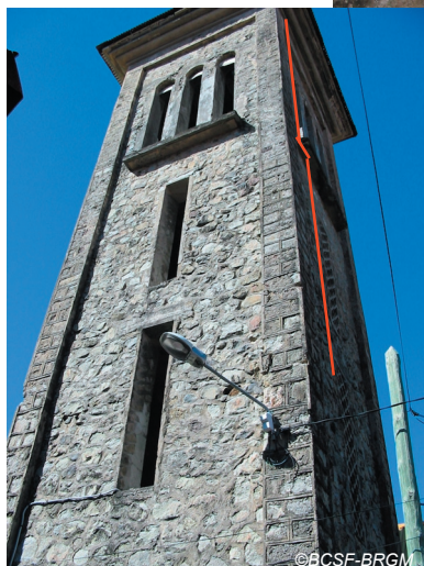
Fig. IV-25. Terre-de-Haut - clocher de l'église.
