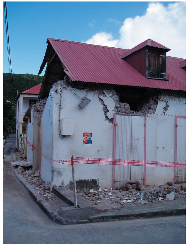
Fig. IV-6. Exemples de constructions en maçonnerie en pierre (moellons) - Terre-de-Bas.
