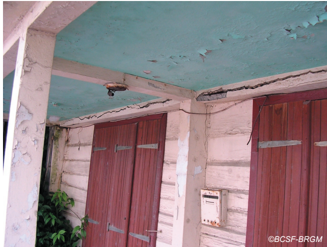
Fig. IV-55. Fissures sur les structures de deux maisons d'habitation anciennes (dommages de niveau 2 sur bâtiment de vulnérabilité B).
