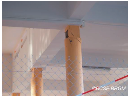
Fig. IV-32. Marché couvert : dommages en tête de poteau, généralisés sur cette structure (dommage de niveau 2-3). On peut suspecter un phénomène de poteaux courts.
