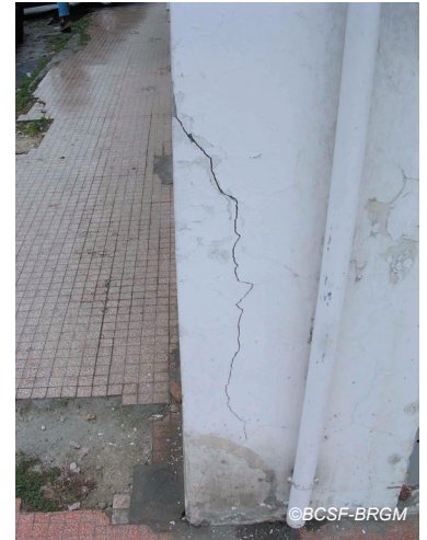
Fig. IV-55. Fissures sur les structures de deux maisons d'habitation anciennes (dommages de niveau 2 sur bâtiment de vulnérabilité B).
