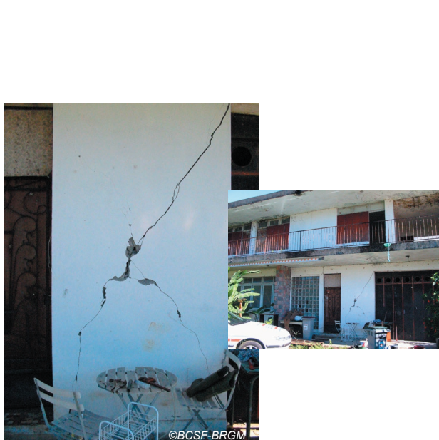
Fig. IV-47. Secteur de Matouba - maison individuelle particulièrement rongée par la corrosion (nombreuses traces d'infiltrations), dégâts de niveau 3, vulnérabilité B.
