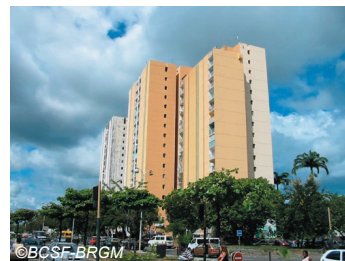
Fig. IV-87. Tours de la Gabarre - sans dégât.
