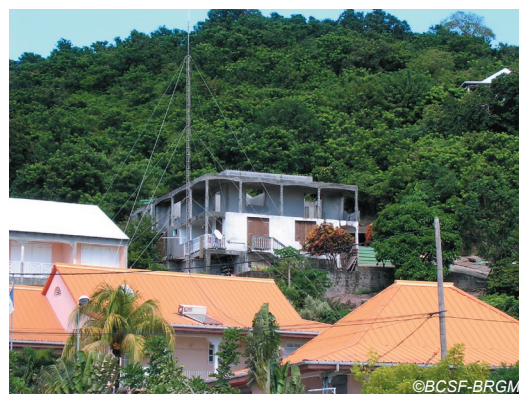
Fig. IV-10. Exemples de constructions de Petites-Anses (proche de la zone la plus affectée) sans dégât apparent.
