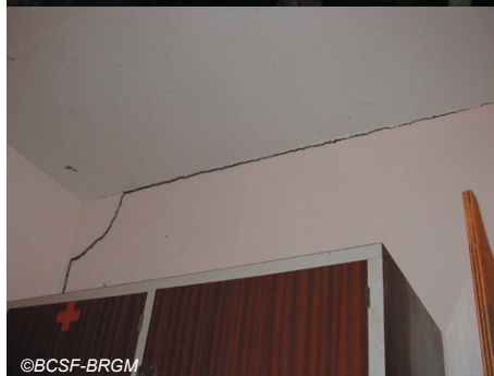
Fig. IV-75. Vieux-Habitants - école du Beau- structure reposant sur pilotis fragilisés.
