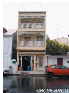
Fig. IV-57. Bâtiment de Grand Bourg n'ayant souffert d'aucun dommage (à gauche) et exemple de bâtiment du vieil hôpital (à droite).
