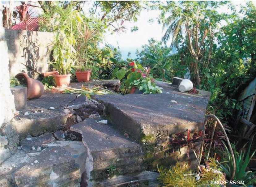
Fig. IV-50. Lieu dit La Plaine. Vue de la maison la plus touchée dans le quartier (niveau 4) et affaissement de terrain au voisinage, au bord de la ravine.
