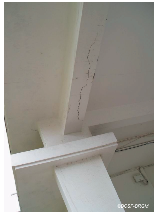
Fig. IV-56. Dommages sur les poteaux du bâtiment principal de l'ancien hôpital de Marie Galante (dommages de niveau 2 et 3 sur éléments porteurs). Le bâtiment est très ancien (vulnérabilité B).
